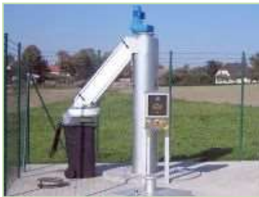
Abb.10 und 11: Siebrechenanlage in vertikaler Aufstellung (Quelle: Huber AG)
